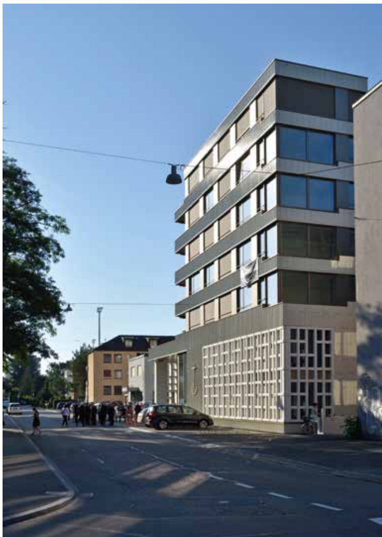
Външен изглед на новата църква в Цюрих-Албисриеден
